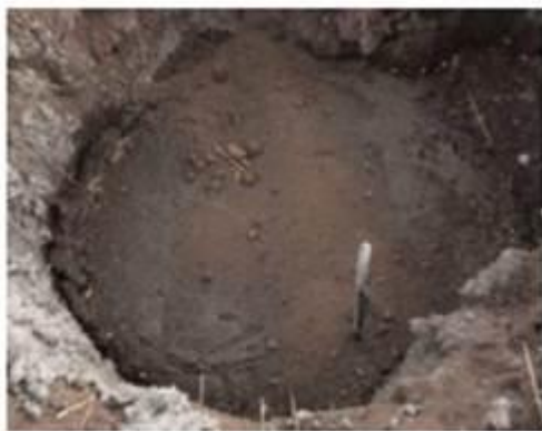
muerto a anclaje de hormigon para viento con gancho de varilla de acero
