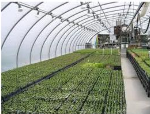
Estructura metálica (tunel)
