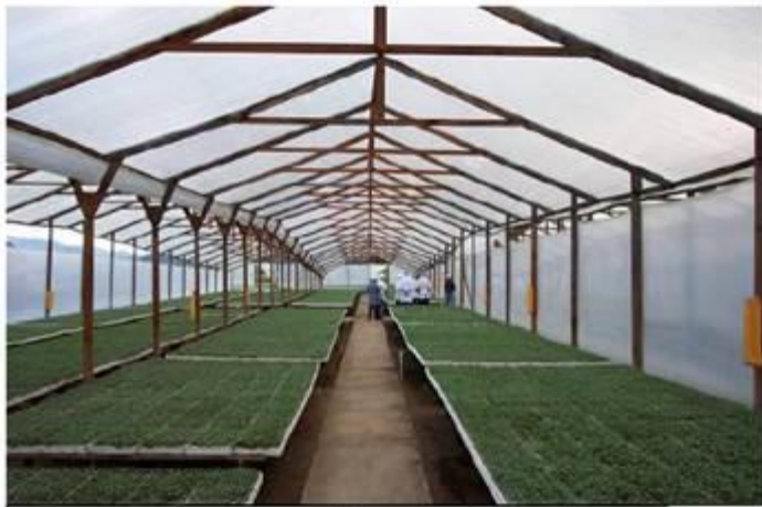
Madera aserrada y alambre el techo
