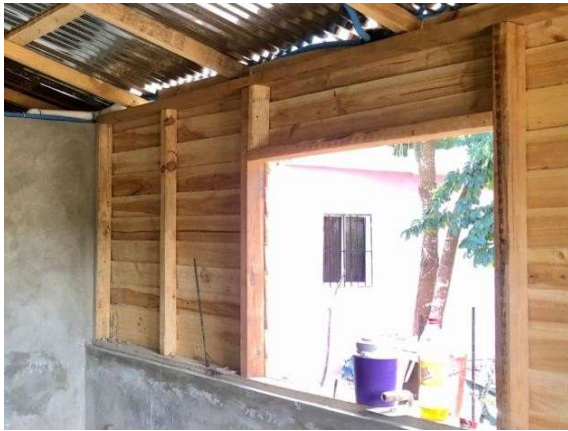
Cabezal de madera 2"x 4" (puertas y ventanas).
