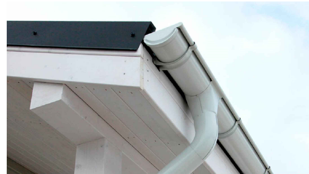
DETALLE DE DESAGUE DE TECHO
