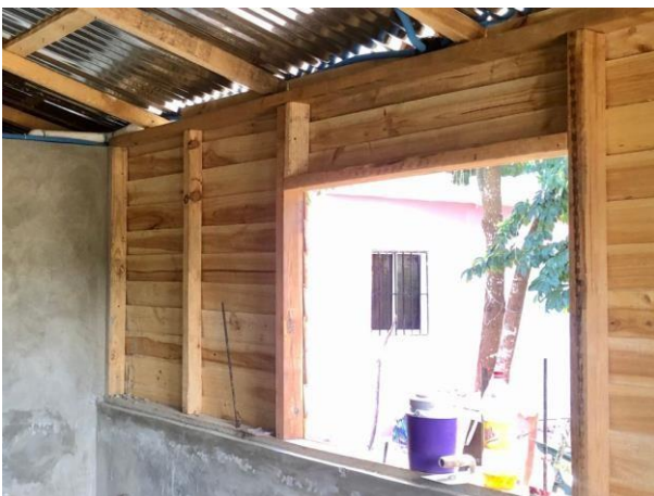
Cabezal de madera 2"x 4" (puertas y ventanas).
