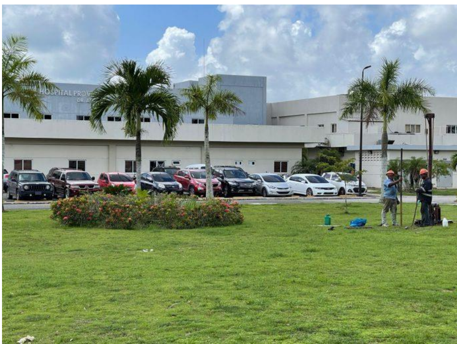
PROYECTO HELIPUERTO HOSPITAL REGIONAL DE MONTE PLATA, DR. ANGEL CONTRERAS MEJÍA Monte Plata.
