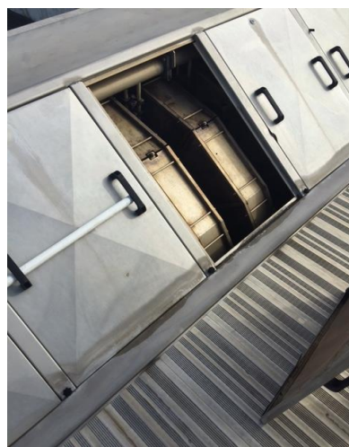
Ilustraciones: fotografías de Noriega 2: grades, tamiz automático y filtración directa
