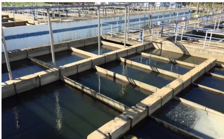
CUADRO 1.0 – ANÁLISIS DE LA FLOCULACIÓN EXISTENTE
