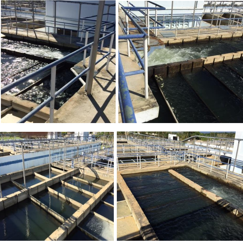
Fotos de la floculación en Noriega 1
