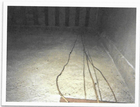
pared oeste en el area posible de almacen
