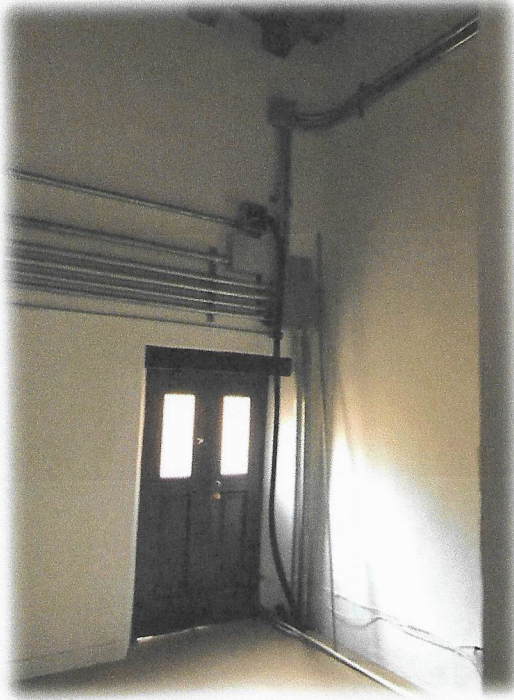
Instalaciones técnicas vistas
