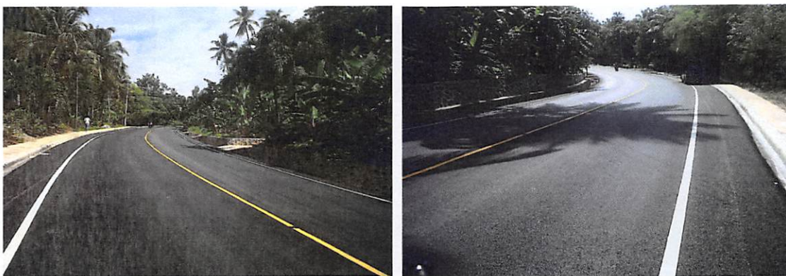
Reconstrucción de la Carretera Samaná - Las Galeras; Provincia Samaná. Obra realizada por CEIZTUR, año 2011.
