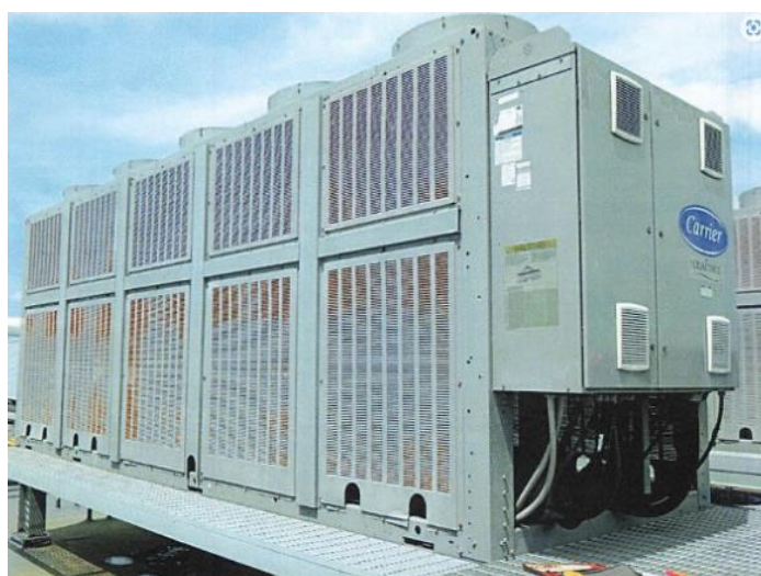
SERVICIO DE MANTENIMIENTO DE PINTURA ANTICORROSIVA PARA TRES (03) CHILLERS DE 160 TONELADAS.
