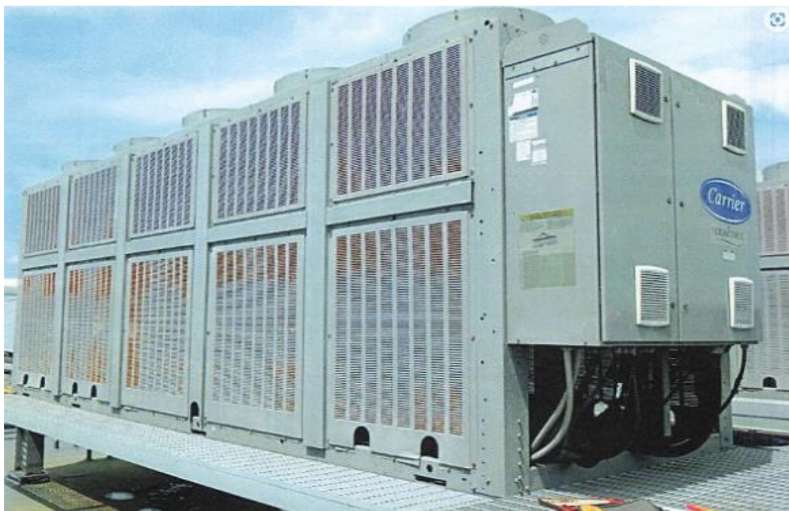
SERVICIO DE MANTENIMIENTO DE PINTURA ANTICORROSIVA PARA TRES (03) CHILLERS DE 160 TONELADAS.
