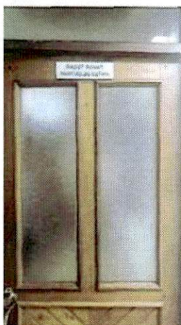
Puerta 1, oficina en lobby.
