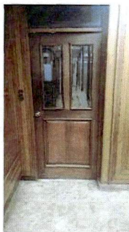
Puerta 2, acceso a oficinas.
