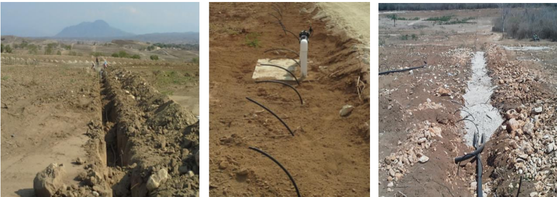
Figura 18. Anclaje en hormigón de piezas especiales.
