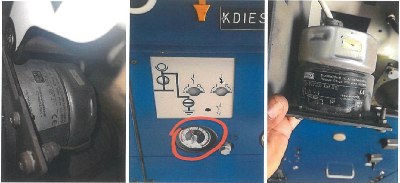
Figura 4. Indicador presión de gas SF6
