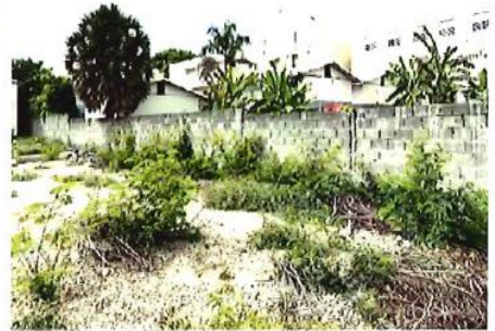
3. Muro Bloques Completo.
