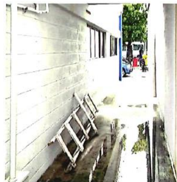
6. Cerramientos en Hierro.
