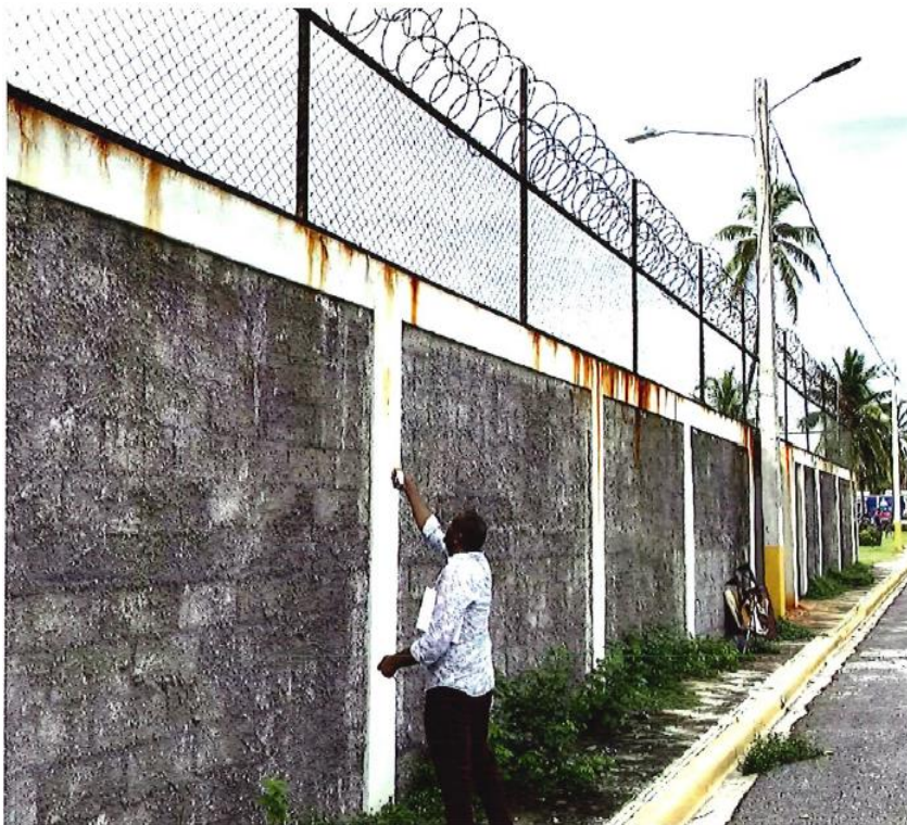
4. Muro Bloques Existente (Referencia).
